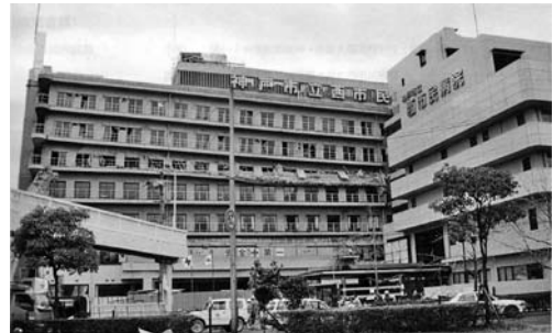
図1 被災時の病院写真
