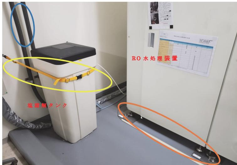
図2 大型装置の固定、フレキシブルチューブ配管
